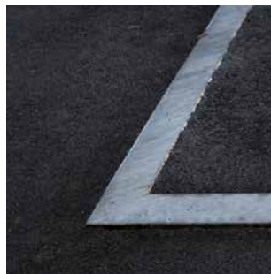
Chapa montada a ras de suelo 30°
